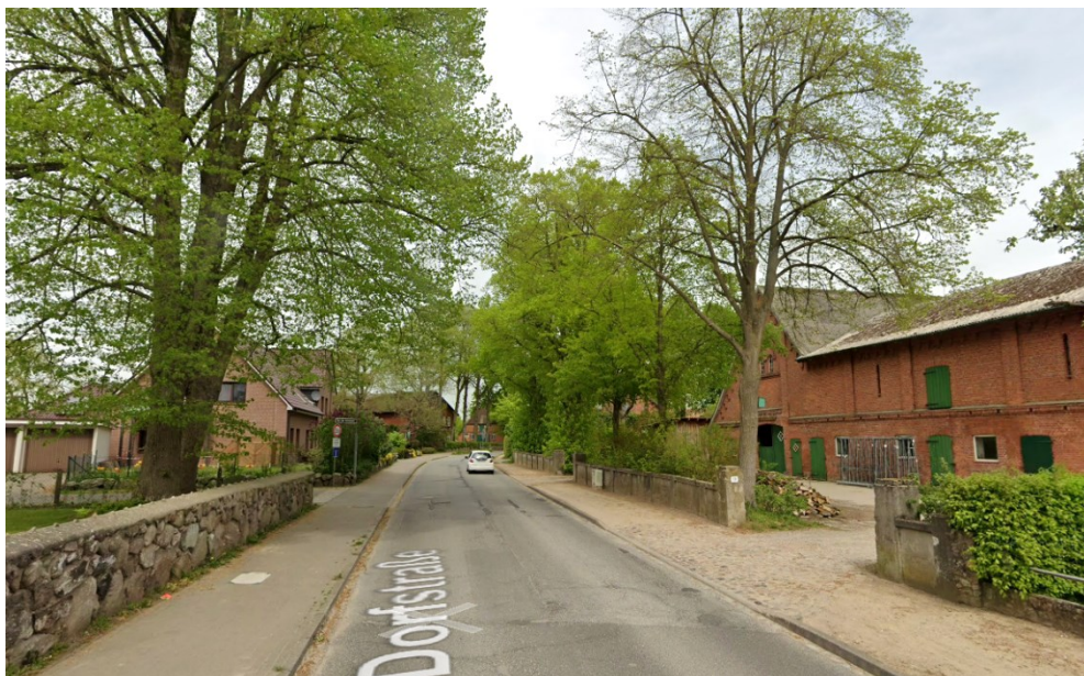
Abb. 7: Steinmauern im Bereich Flurstücke 29/2, 38/4, 36/1, Aufnahme Google Maps – Streetview
