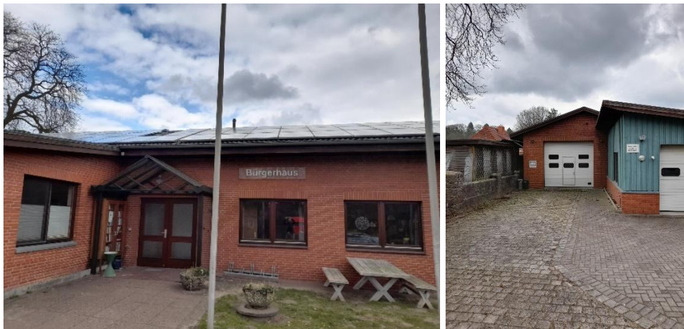
Abbildung 6-31: Außenansicht Bürgerhaus und Feuerwehrgerätehaus mit Anbau (v. l.)
